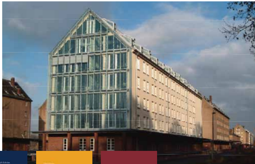
Seit 2001 Domizil des Verlags: Die neue Speicherstadt, ehemalige Winterbourne-Kaserne in Münster-Coerde.
